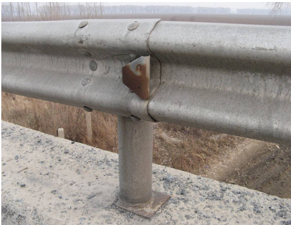
图 2-42 附着式轮廓标破损
