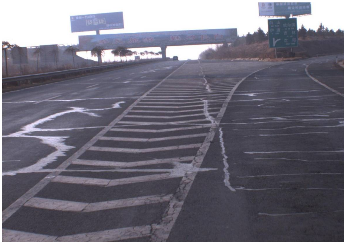
图 2-12 路面裂缝
