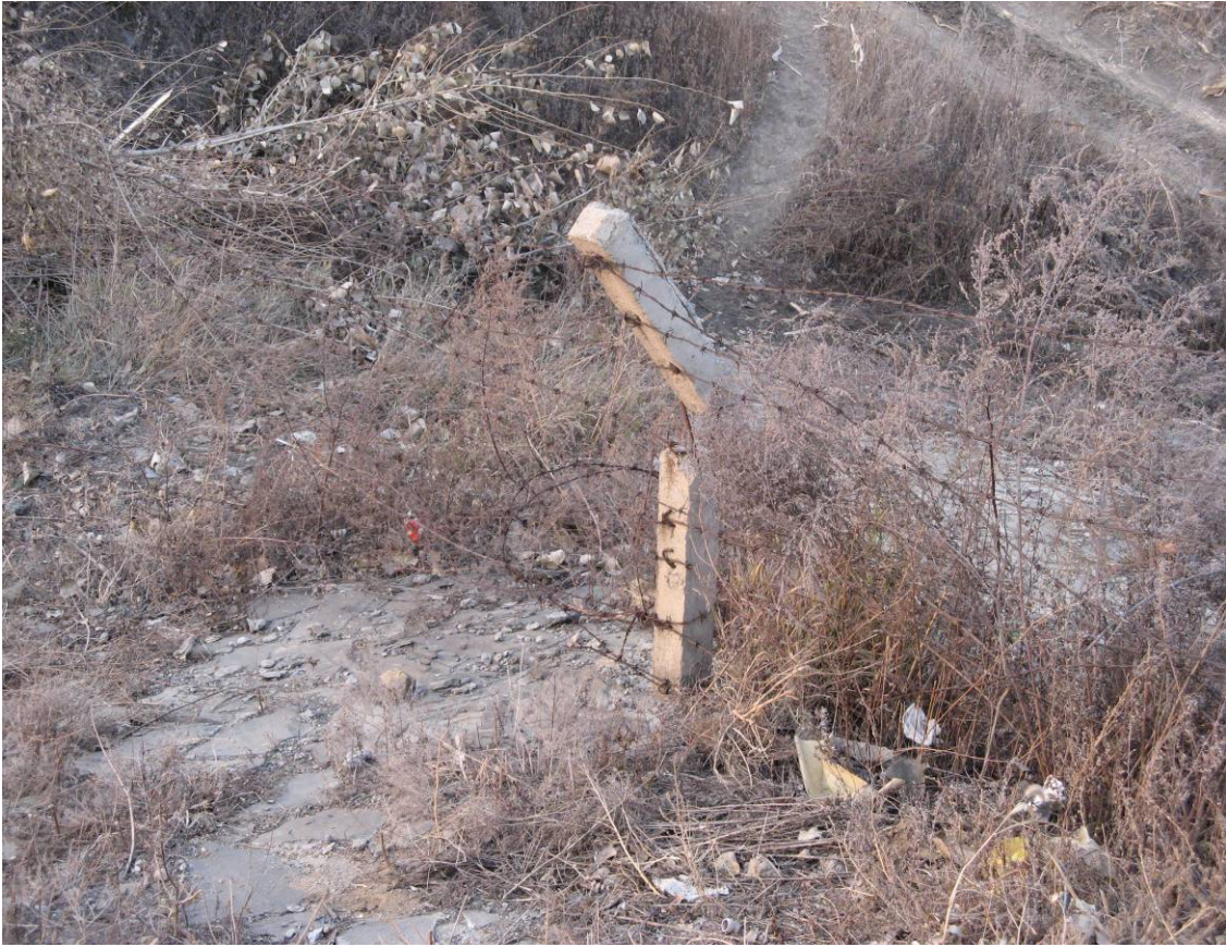
图 2-44 刺铁丝隔离栅破坏
