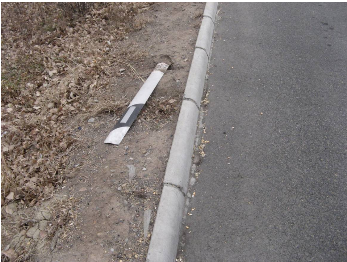
图 2-41 柱式轮廓标折断
