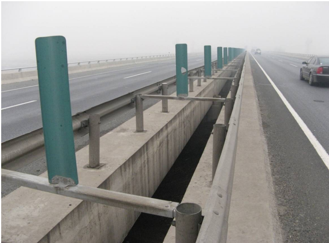
图 2-45 防眩板破损
