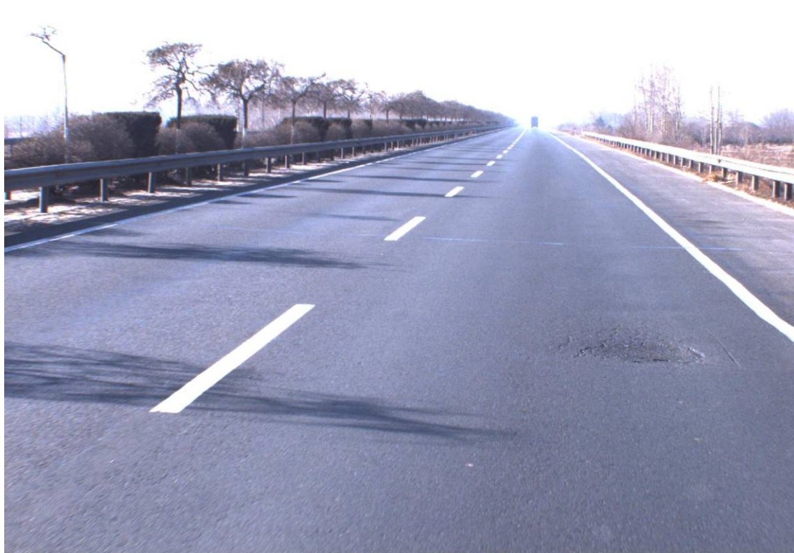
图 2-13 路面坑槽
