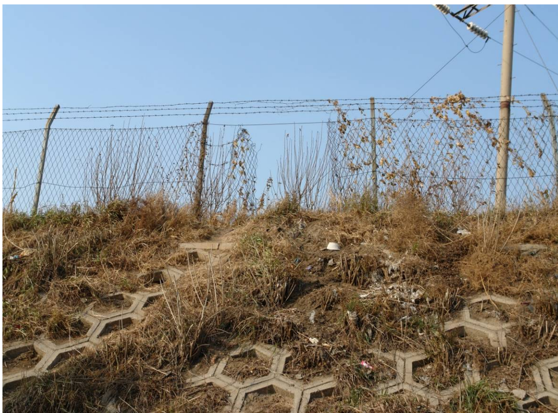
图 2-43 编织网隔离栅破坏
