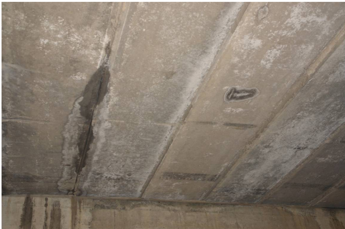
图 2-25 铰缝漏水
